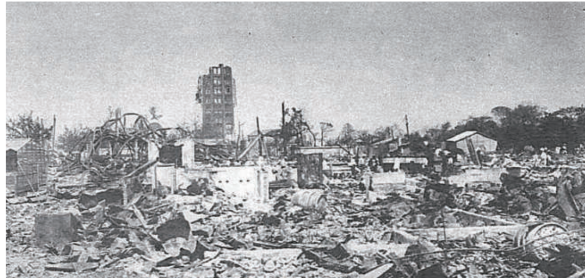
被災直後の9月7日に撮影された、倒壊した浅草の「凌雲閣」。12階建てが途中から折れている (東京市編纂「東京震災録 地図及写真帖」より 提供：公益財団法人 後藤・安田記念東京都市研究所市政専門図書館所蔵資料)
