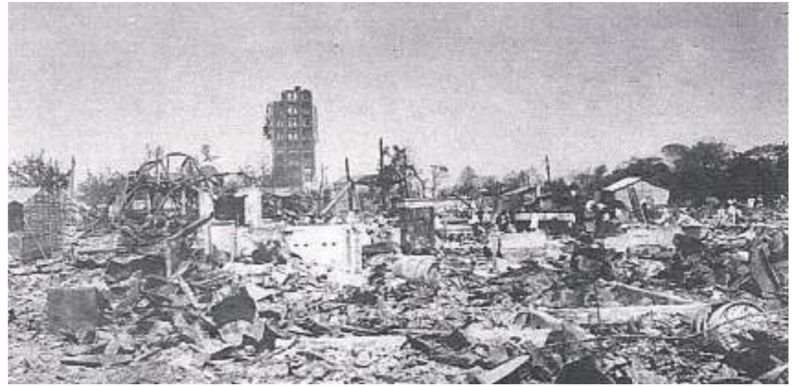
被災直後の9月7日に撮影された、倒壊した浅草の「凌雲閣」。12階建てが途中から折れている (東京市編纂「東京震災録 地図及写真帖」より 提供：公益財団法人 後藤・安田記念東京都市研究所市政専門図書館所蔵資料)
